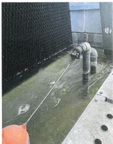
รูปที่ 3-19 การติดตามตรวจสอบคุณภาพน้ำ ที่ออกหอผึ่งเย็น จุดน้ำไหลเข้ามาเติมในระบบ
