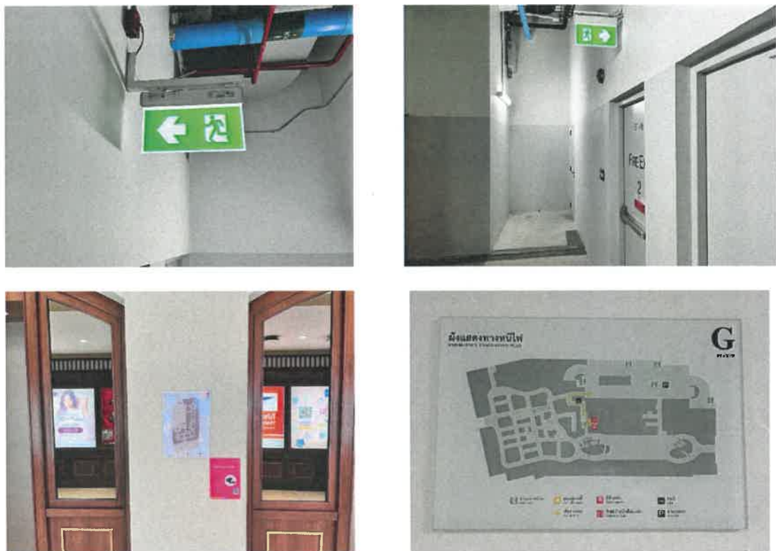
รูปที่ 3-13 การติดตามตรวจสอบป้าย เครื่องหมายแสดงการหนีไฟ และแผนผังเส้นทางหนีไฟ
