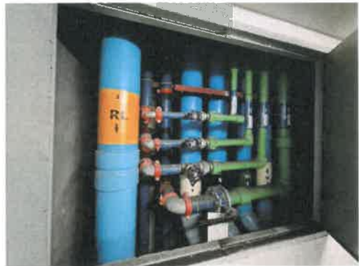
รูปที่ 3-7 การตรวจสอบเส้นท่อประปาและวาล์วควบคุมการจ่ายน้ำ
