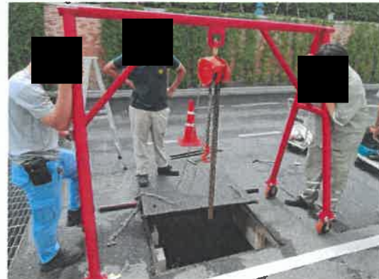
รูปที่ 3-6 การตรวจสอบเครื่องสูบน้ำภายในบ่อหน่วงน้ำ
